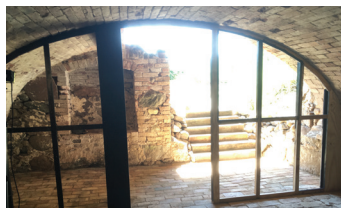
Blick aus dem Gewölbe
